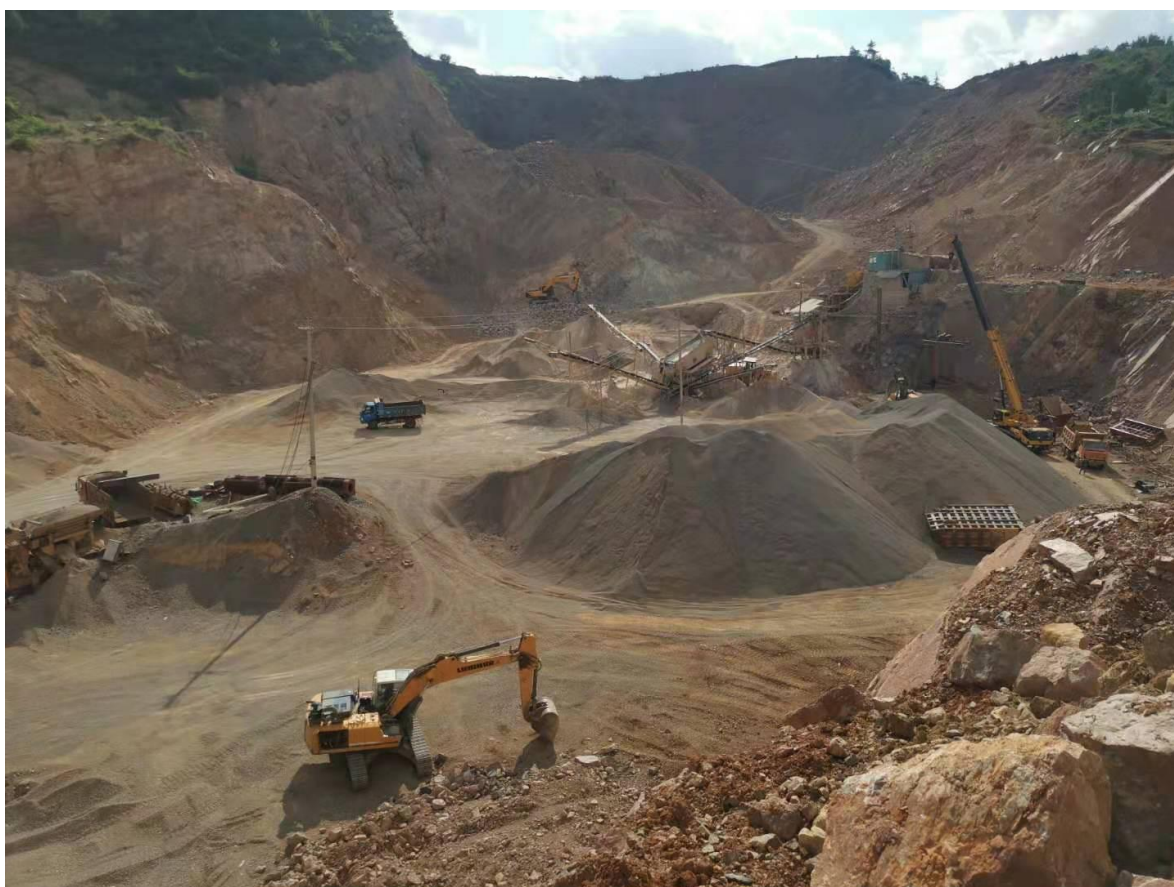
照片 1-1 矿山采矿现状
