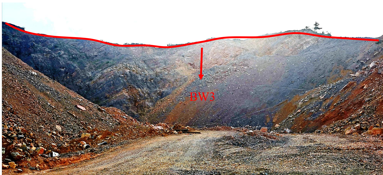
照片 3-3 露天采场中部不稳定斜坡 BW 3
