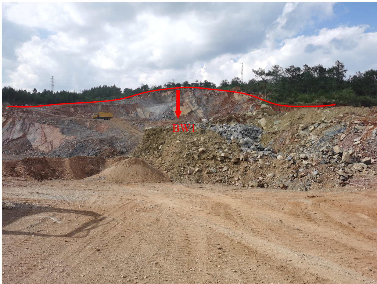
照片 3-1 露天采场北东部不稳定斜坡 BW_1
