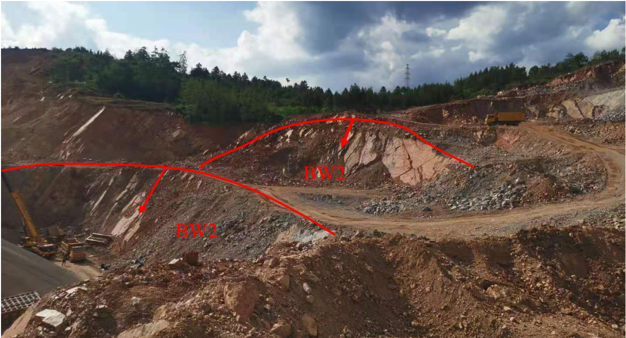
照片 3-2 露天采场中部不稳定斜坡 BW 2
