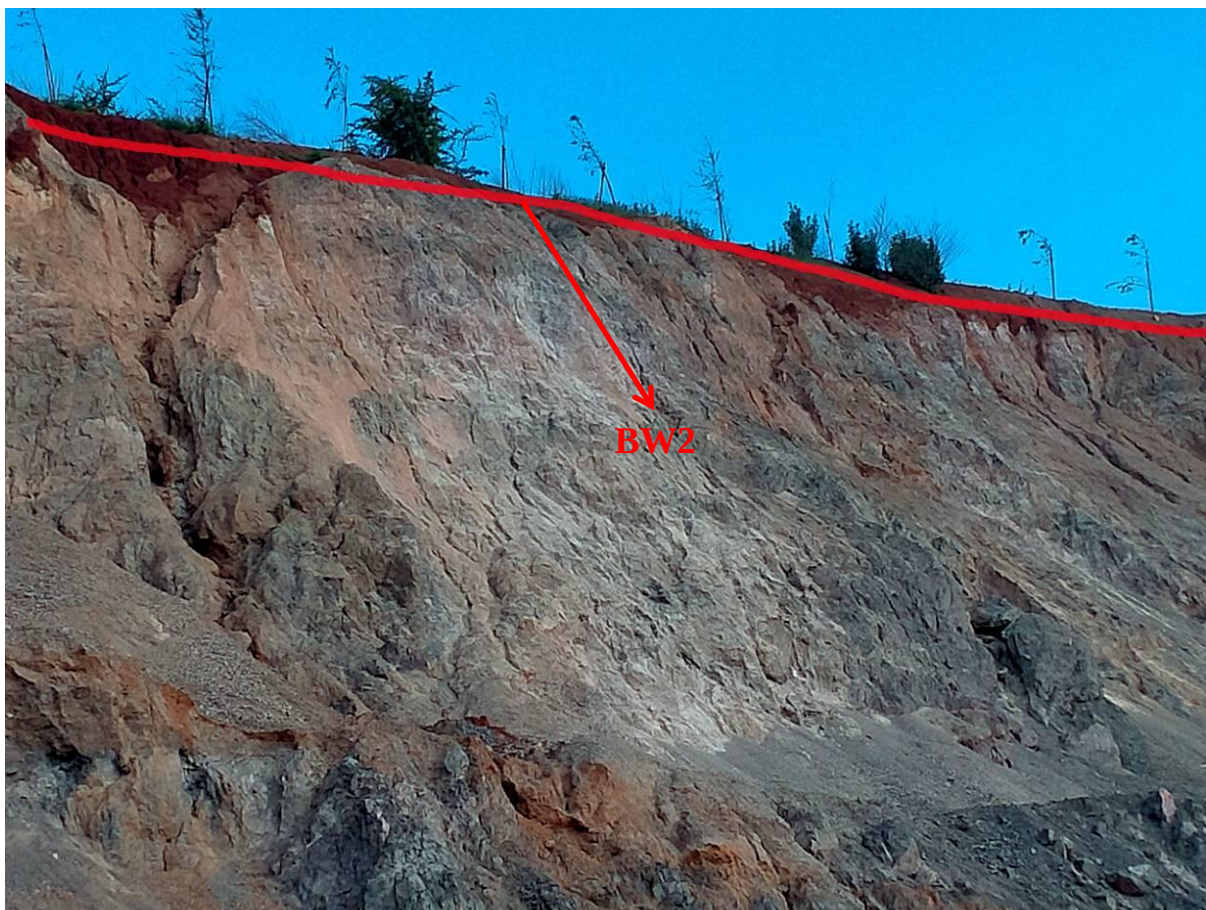
照片 3-2 露天采场中部不稳定斜坡 BW 2
