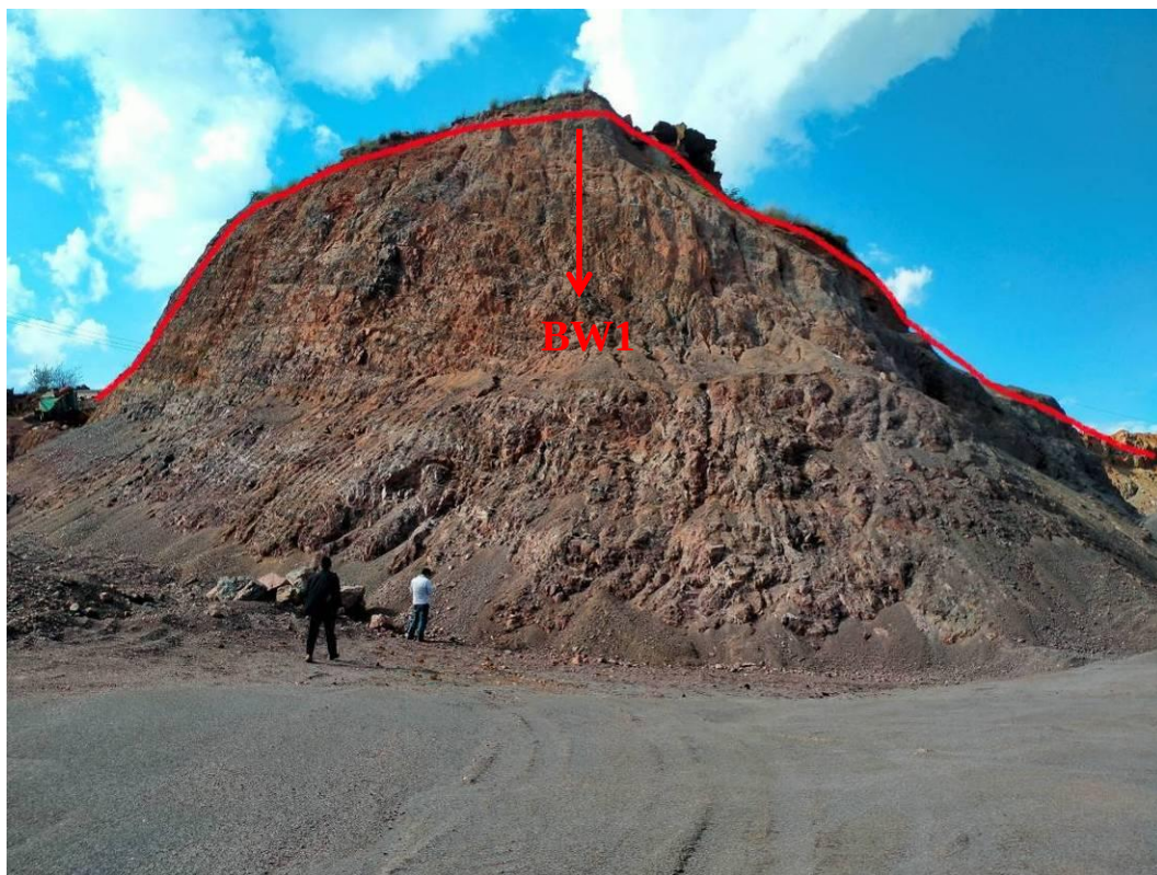
照片 3-1 露天采场西部不稳定斜坡 BW 1
