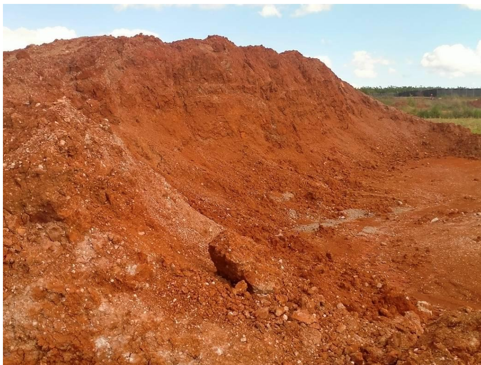
照片 4-1 已损毁土地剥离表土堆存情况
